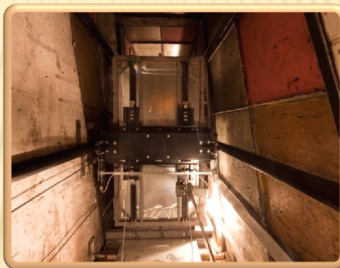
rám kabíny s obojsmernými zachytávačmi a vodiacimi čalustami so samomazačmi
