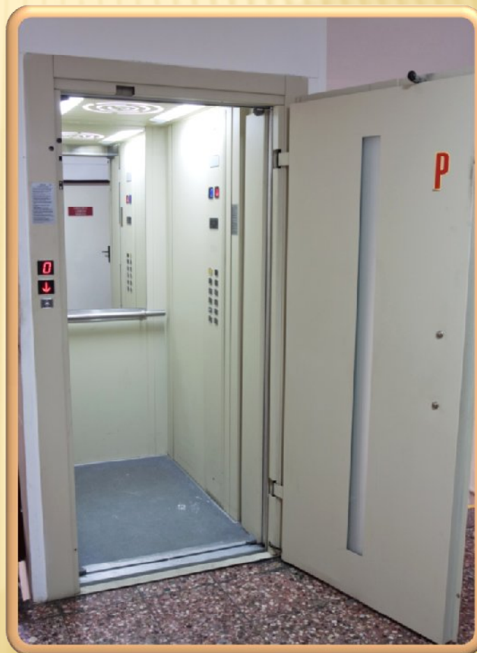
nová kabína s kabínovými dverami a novými ručnými šachtovými dverami
