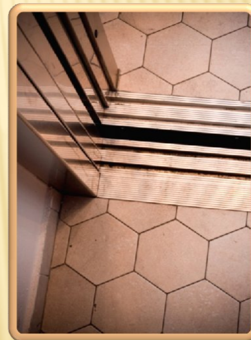
presné zastavenie, detail kabínových a šachtových dverí
