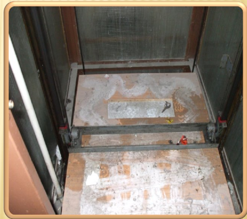
spodný záves lán pôvodná kabína bez samomazov
