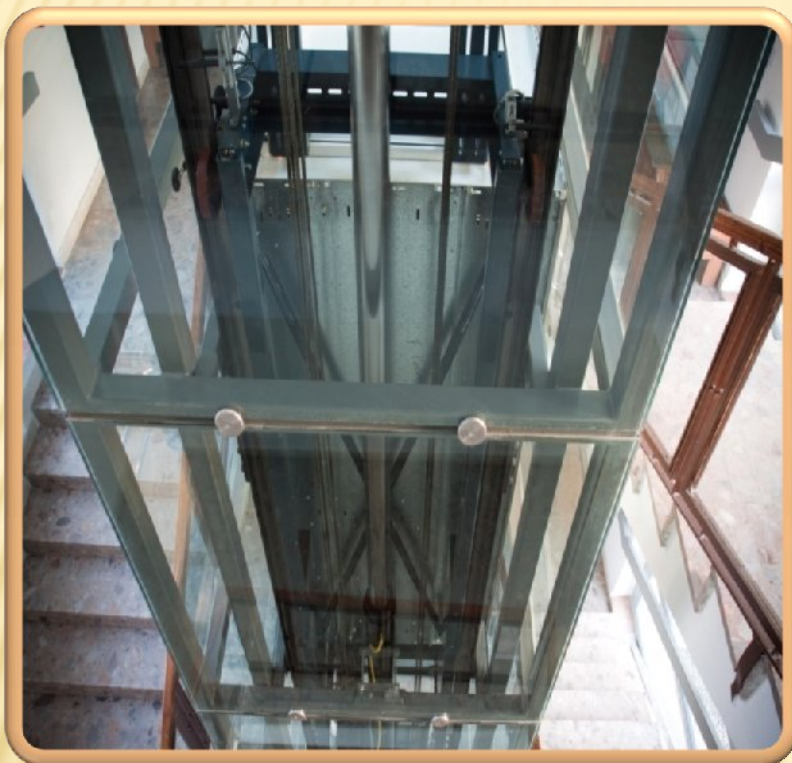
hydraulický piest s lanami pre lanovanie 2:1
