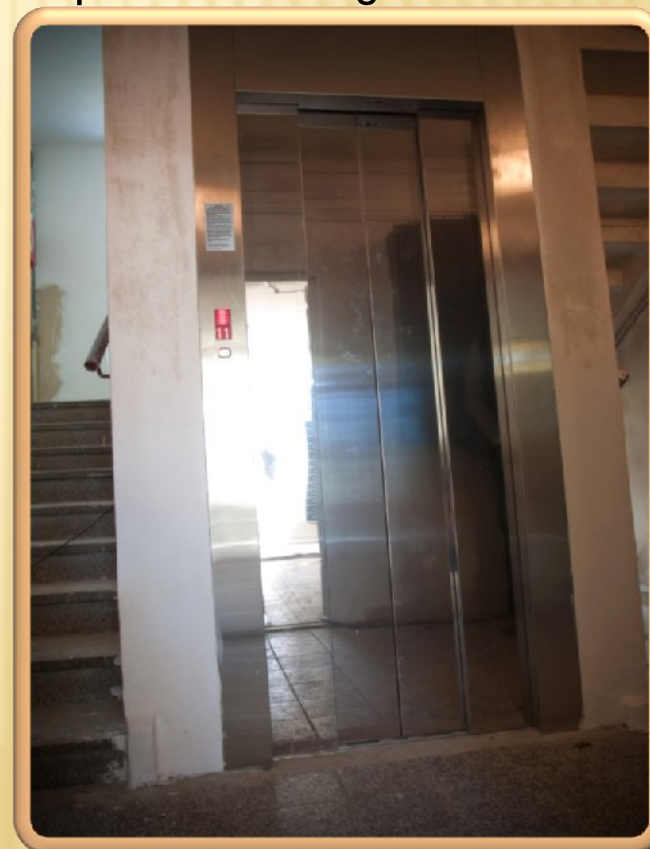
4-panelové centrálné dvere so zárubňou a privolávačom s polohovou signalizáciou
