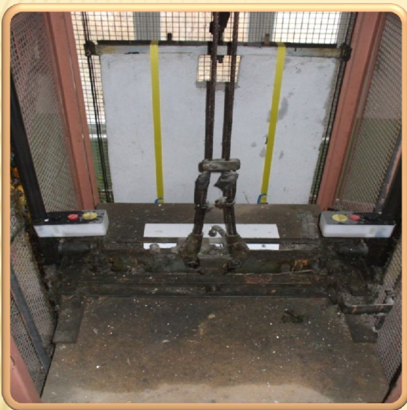
pôvodná protiváha vzadu kabína s horným závesom
